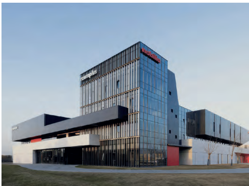
Erster Bauabschnitt in Wuxi
