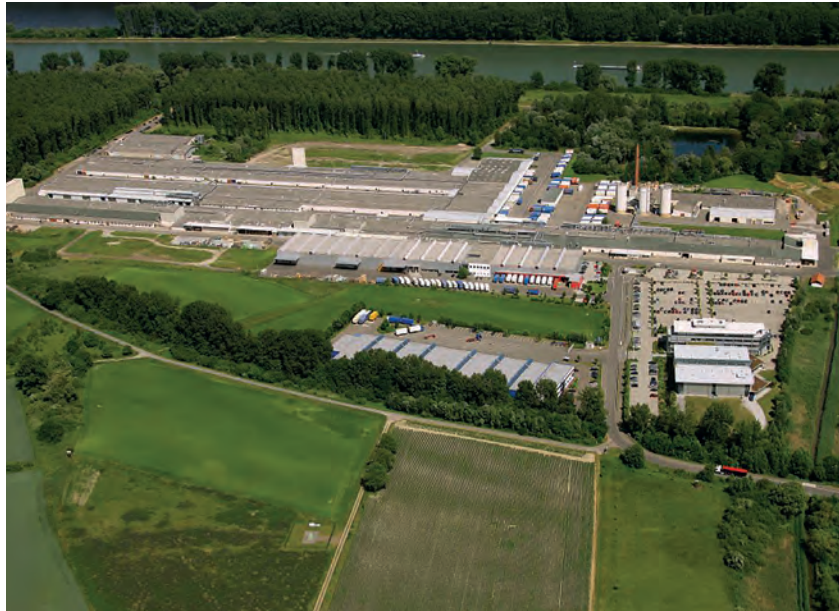
Nolte-Möbelwerk in Germersheim
