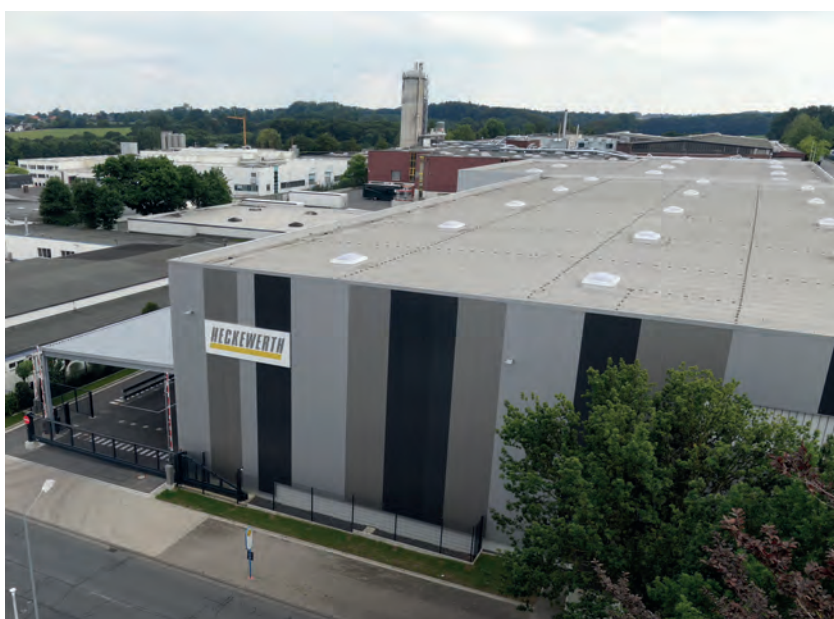
Heckewerth baut seine Kapazitäten im Werk Hiddenhausen aus.
