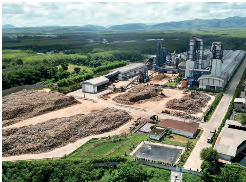
Spanplatten- und MDF/HDF-Werk von Panel Plus in Hat Yai
